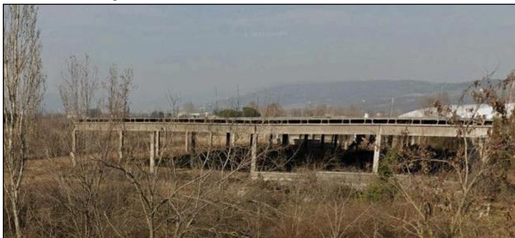
Fotografia illustrativa dello stato del fabbricato esistente.
