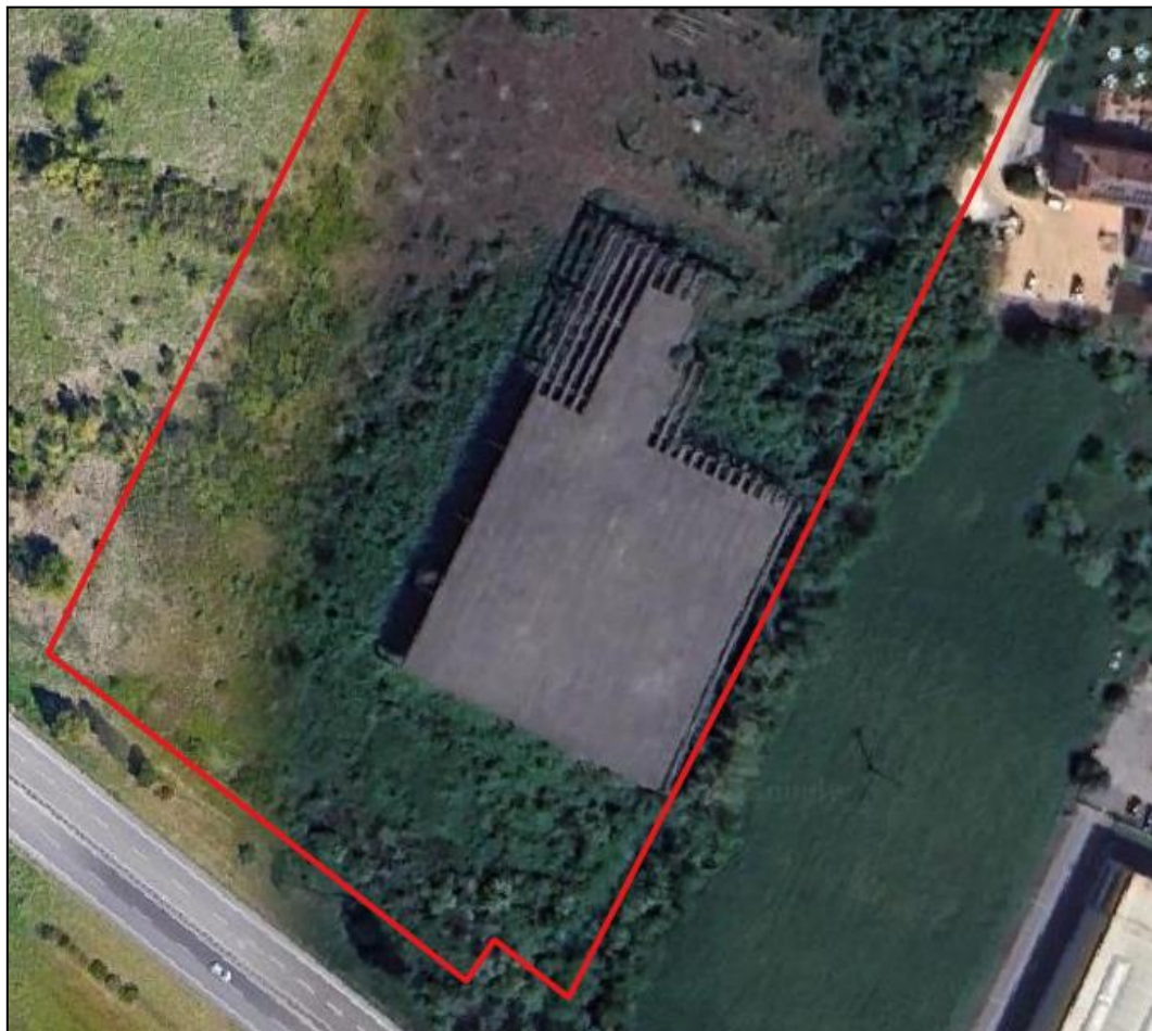
Individuazione del fabbricato esistente su ortofoto
